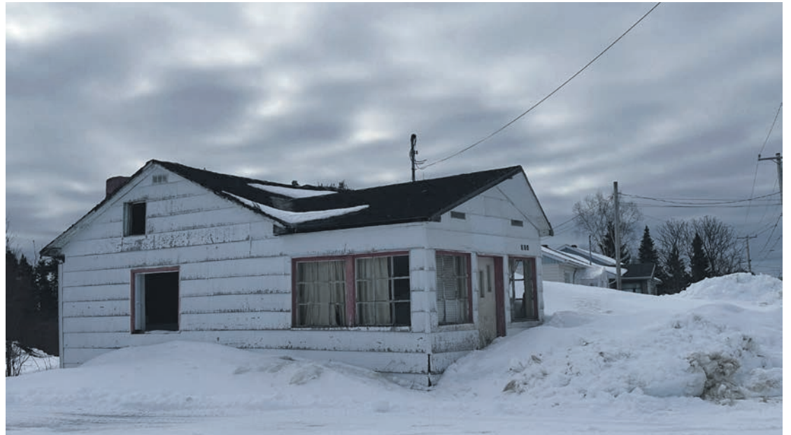
La résidence située au 294, 9 e rue n'existera plus après les travaux de l'entrepreneur. Photo Johannie Gaudreault
