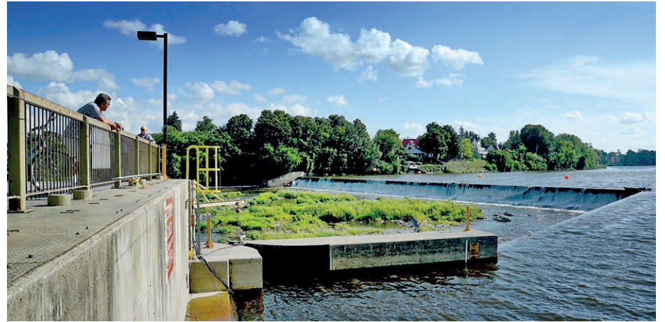
Le débit d'eau réservé à la rivière Yamaska à l'entrée de la centrale devra demeurer d'au moins 9 m 3 /s du 1 er juillet au 7 septembre. Photothèque | Le Courrier ©
