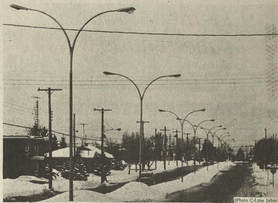
Tous les lampadaires sont installés, sur le boulevard Leclerc, des rues Saint-Viateur à Principale. Ils n'attendent que l'arrivée de transformateurs.
