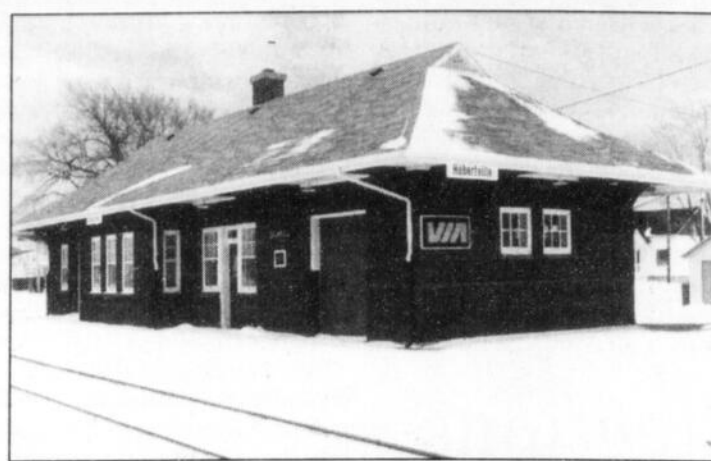
PATRIMOINE - Toujours en excellent état, la gare ferroviaire d'Hébertville-Station est devenue la première de la région à obtenir le titre de patrimoine national, hier.
