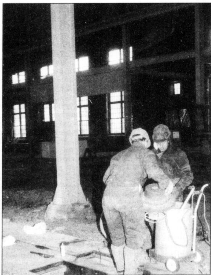
TRAVAUX - De nombreux travaux permettront aux visiteurs de mieux connaître l'histoire de la Pulperie et de notre région et ce, dès juillet prochain.
