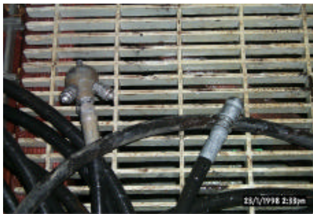
Figure 14: Exemples de buses utilisées pour le nettoyage au furet
