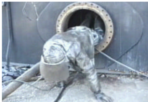
Figure 22: Sortie d'un réservoir ou trou d'homme
