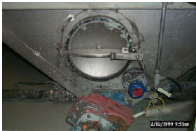
Figure 21: Porte d'accès à un espace confiné ou trou d'homme (diamètre 46 cm/18 po)
