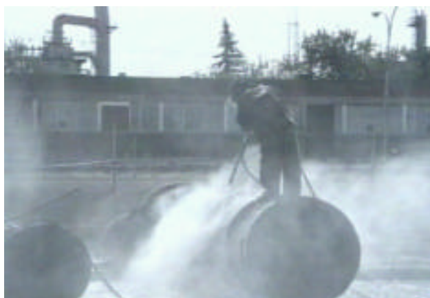
Figure 20: Nettoyage manuel de l'extérieur d'un échangeur
