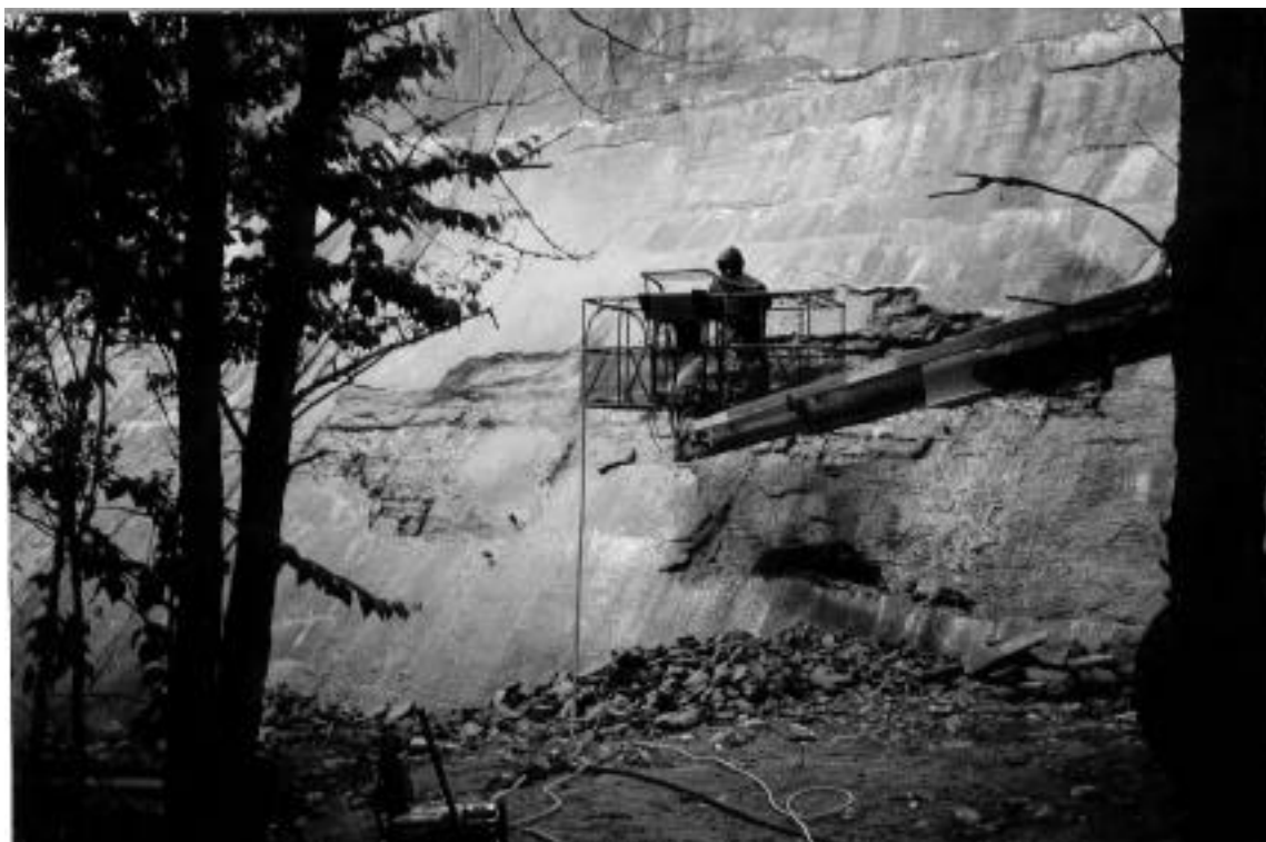
Figure 24: Travail en hauteur d'une nacelle
