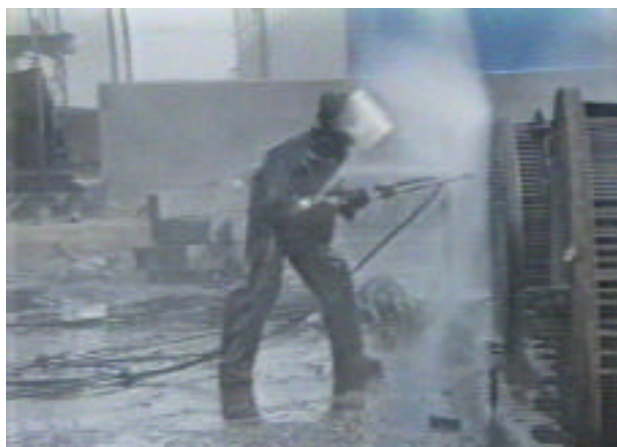
Figure 9: Visière relevée dans le cas d'une opération requérant un contrôle visuel
