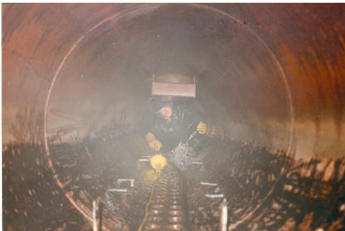
Figure 23: Travail à l'intérieur d'un espace clos
