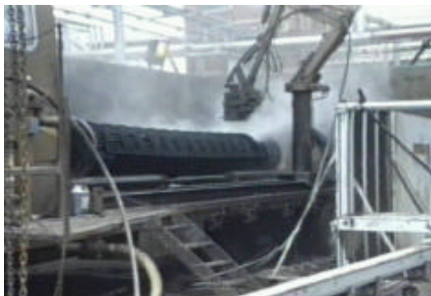
Figure 18: Nettoyage de l'extérieur d'un échangeur à l'aide d'une machine de nettoyage à distance
