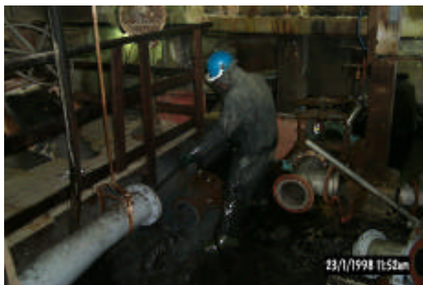
Figure 13: Nettoyage au furet d'une conduite
