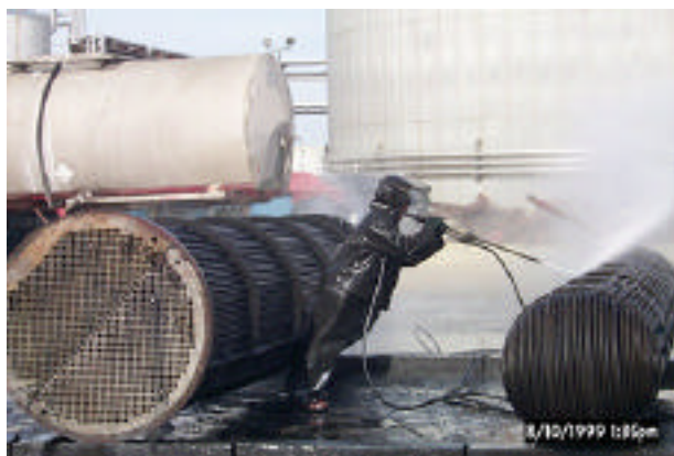
Figure 10: Nettoyage manuel de l'extérieur d'un échangeur au fusil de 1 m
