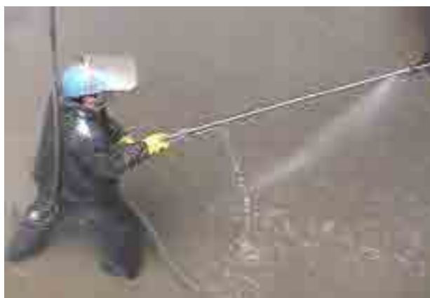
Figure 8: Nettoyage des parois d'une cale de bateau
