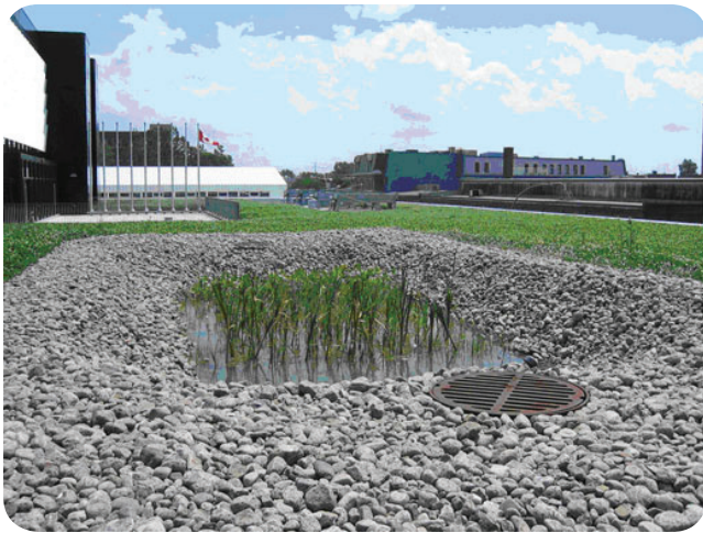
Image 15- Bassin de rétention d'eau extérieur – 740, Bel-Air, Montréal
