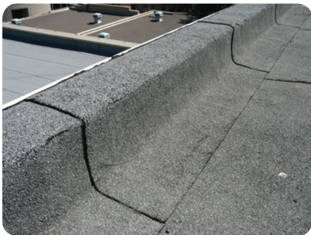
Image 19- Membrane élastomère, Pavillon Sherbrooke, UQAM
