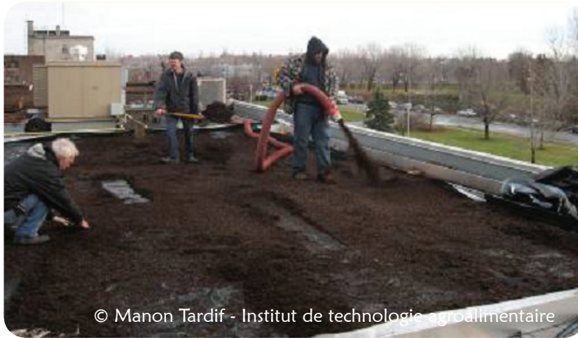
Image 12- Terreau soufflé pour le projet de l'ITA à Saint-Hyacinthe
