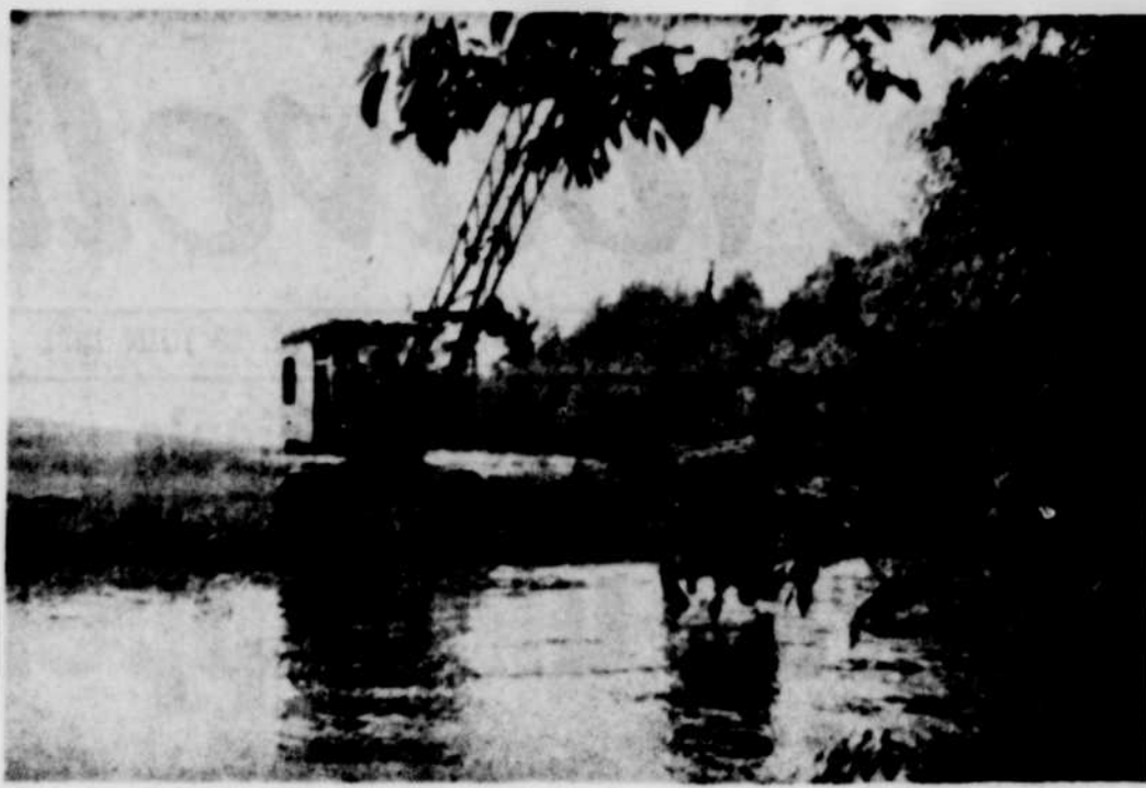
UNE GRUE MECANIQUE de la Compagnie Dollard Construction a creusé le petit lac artificiel que nous pouvons voir sur la photo et qui est situé dans le rang St-Félix à Mont-Carmel. Ce travail permettra aux scouts de la troupe Notre-Dame-du-Cap de faire leur camp à cet endroit et se baigner à l'aise. Les services de cette grue furent offerts gratuitement par les directeurs de la compagnie.
