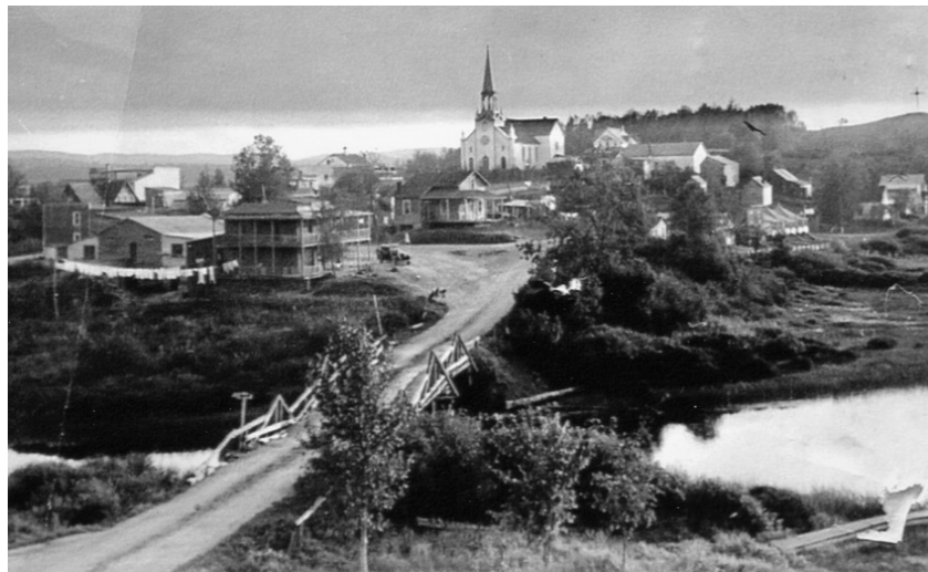
Sainte-Anne dans les années 1930? L'automobile ressemble à celle de la photo plus haut. Complètement à droite au fond, le magasin.
