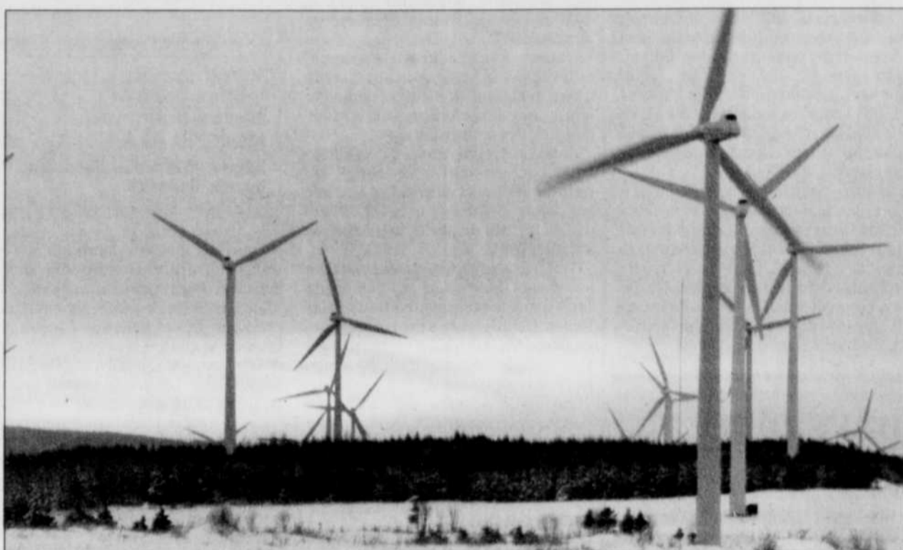
Les éoliennes installées dans le Bas-Saint-Laurent auront une capacité de 1,5 MW, semblables à celles de Murdochville. Elles domineront le paysage avec une hauteur de 80 mètres.
