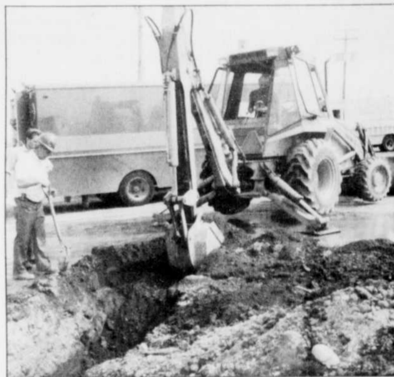
Les employés de Gaz métropolitain ont dû creuser un trou pour rejoindre le système de distribution de gaz qui a, par la suite, été coupé. (Photo Yves Champoux)
