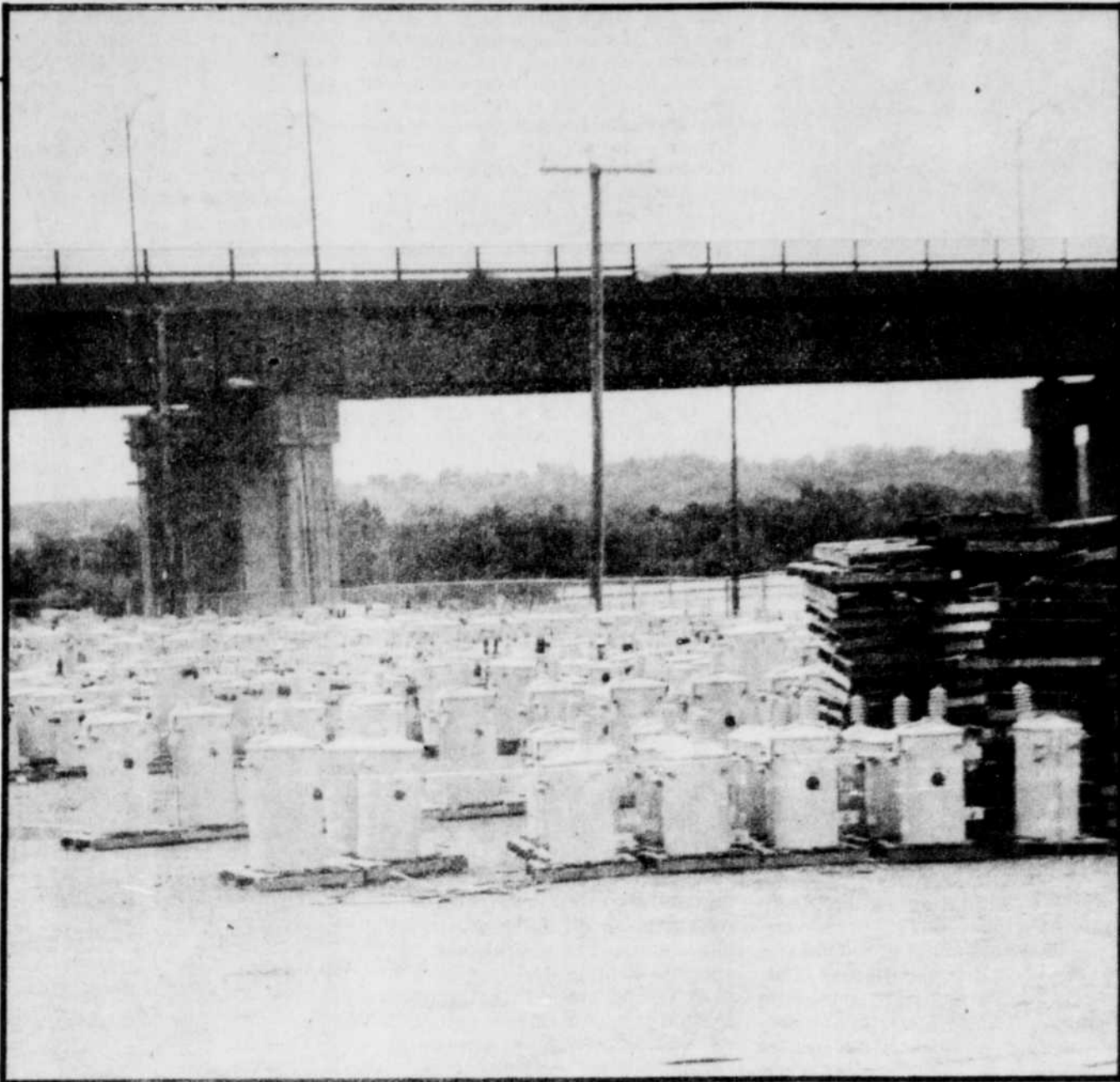
Le propriétaire de Jet de sable de Sherbrooke a dû assumer les frais de nettoyage de 1200 transformateurs entreposés près du pont.
