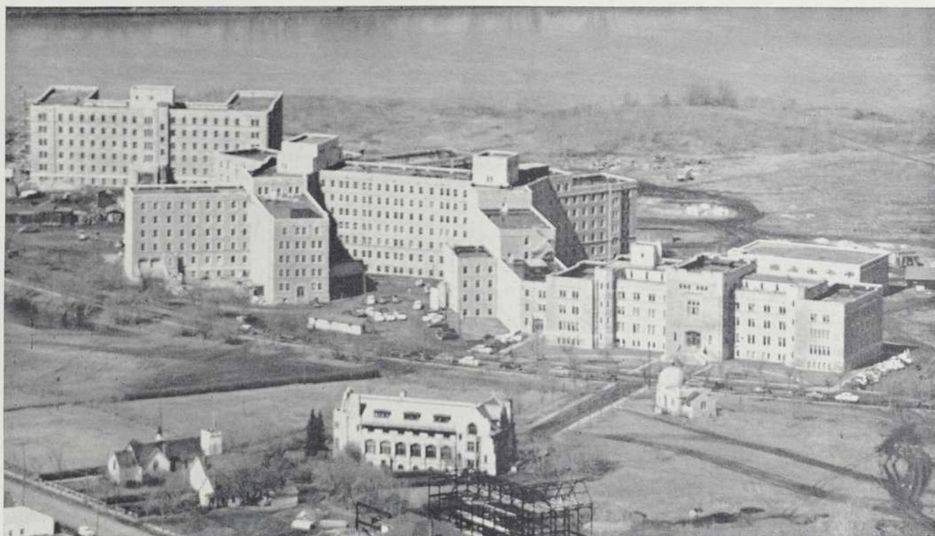
Nouvel hôpital de l'université de la Saskatchewan, à Saskatoon. Sept ailes à huit niveaux différents. Architectes : Webster & Gilbert. Architectes conseils : Govan, Ferguson, Lindsay, Kaminker, Maw, Langley and Keenleyside. Entrepreneurs généraux : Smith Brothers and Wilson.
