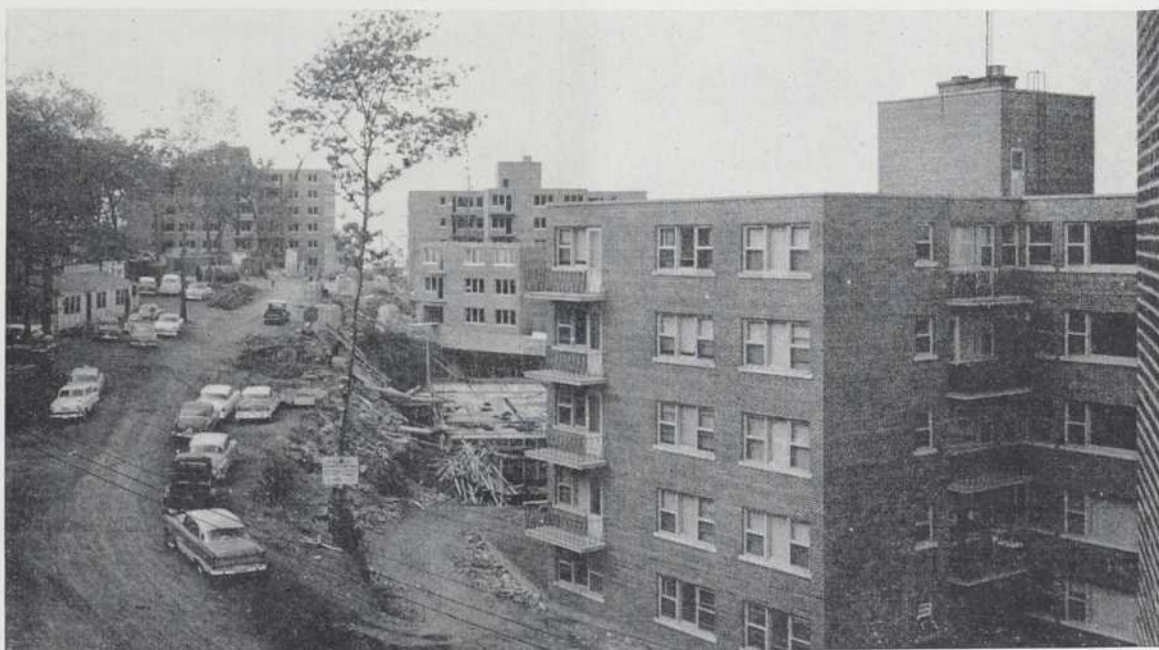
Vue partielle du chantier Upper Ridgewood — 5 des 8 bâtiments de 44 lobements chacun
