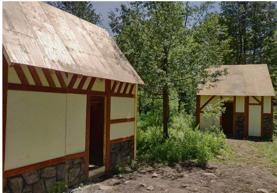
L'Atelier du loisir a construit de nouvelles maisonnettes sur son site à Béthanie pour y accueillir des campeurs cet été. Photo tirée de Facebook
