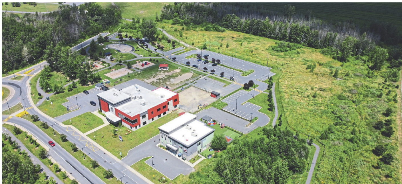
Les terrains de pickleball seront aménagés entre le stationnement derrière l'école Vision et le boisé du parc des Colibris.
