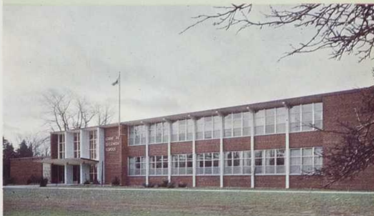
EN ONTARIO ÉCOLE SECONDAIRE LORNE PARK, PORT CREDIT, ONT. Architectes: Hanks Irwin & Pearson, Toronto, Ont. Fournisseur d'aluminium: AlSCO Products of Canada, Limited
