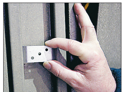
La planche pour pontage DEXX est creuse au centre et profilée de chaque côté. Préalablement fixés sur la structure, des clips viennent s'insérer sur simple pression du pied dans la travée centrale creuse. Ils tiennent par une pression exercée de chaque côté contre les profilés.
