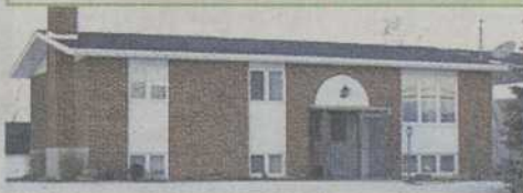
CH0599 Secteur Saint-Thomas-d'Aquin. Bungalow 10 pces, 5 cac, s/sol pour commerce ou loyer avec sortie ext., beaucoup rénovations faites, gr. terrain, garage détaché, chauffé et isolé. Taxes minimales, zonage comm., rue achalandée. Faites vite! Inf. : Isabelle Tétreault
