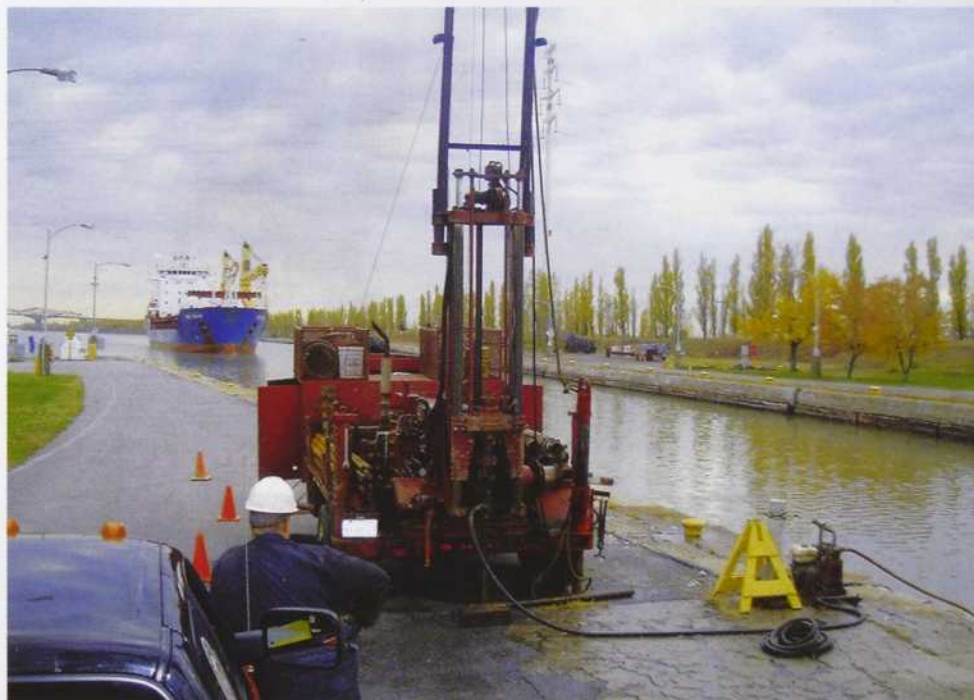
Auscultation sur des ouvrages de génie civil.
