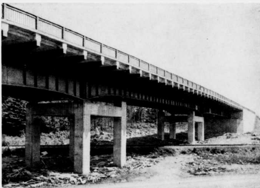
Structure du viaduc au-dessus des voies du C.N.R. sur l'Autoroute Montréal-Laurentides à St-Jérôme
