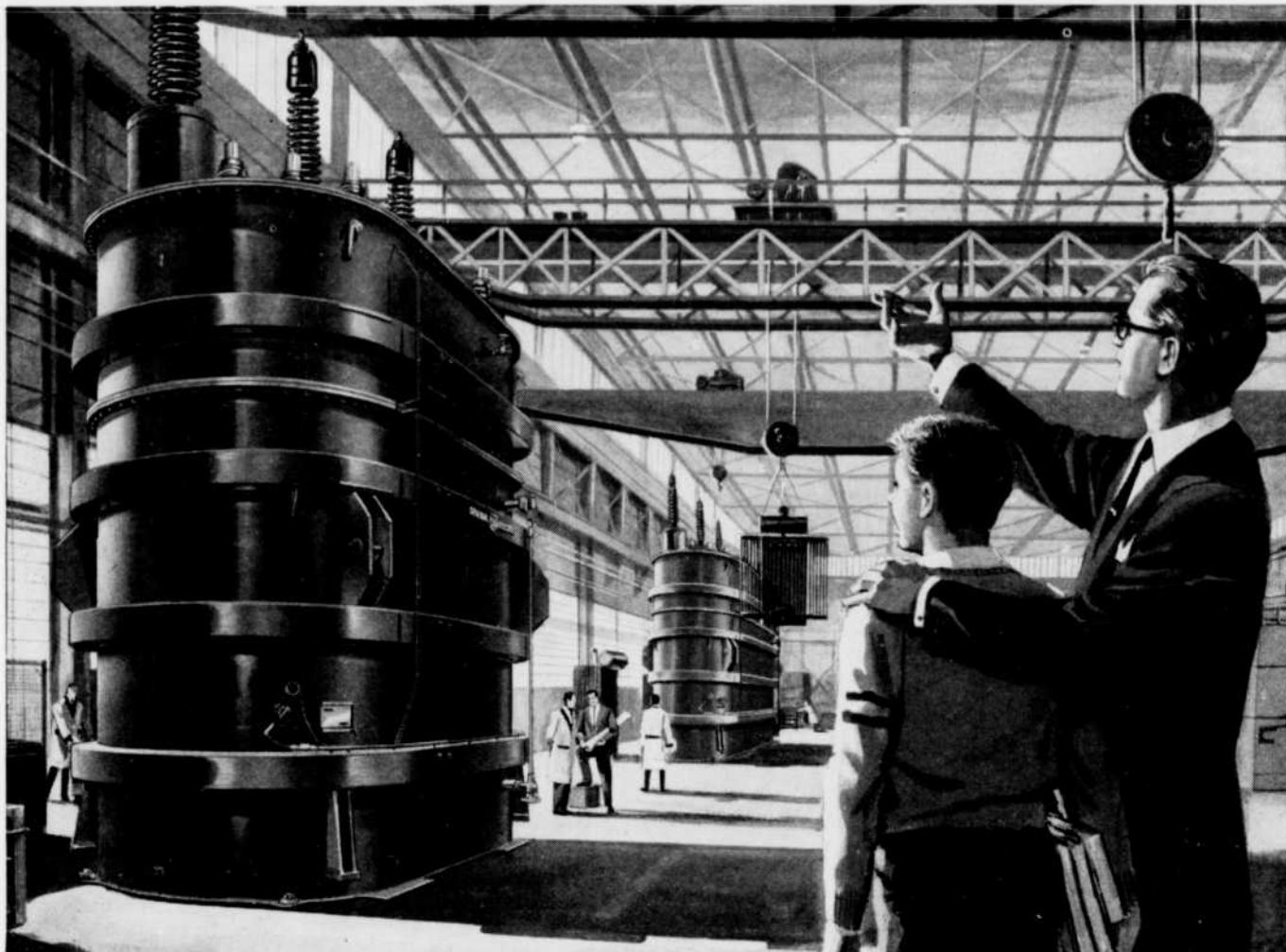
Usine des transformateurs C.G.E. à Guelph, Ontario
