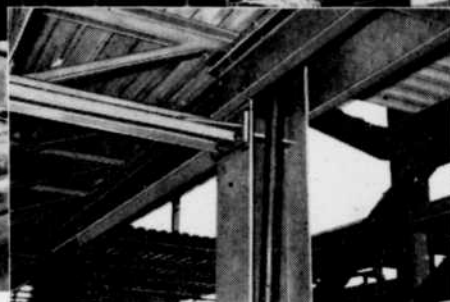
EN PLUS DE BÉNÉFICIER de poutres de planchers continués à hauteur peu profonde, des feres en U disposés sur les faces des colonnes permettent de situer plus efficacement les courses verticales de tuyaux.
