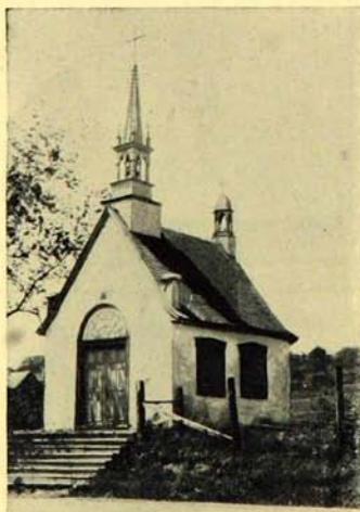
Old chapel at l'Ange Gardien, on the Québec-St. Siméon Highway.
