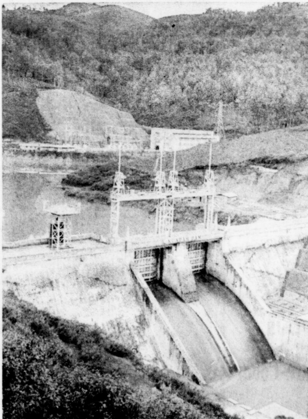
L'ON VOIT CI-DESSUS une partie de l'immense chantier du barrage Kundah, dans l'Etat indien de Madras. C'est l'une des plus vastes entreprises du Canada en Inde.
