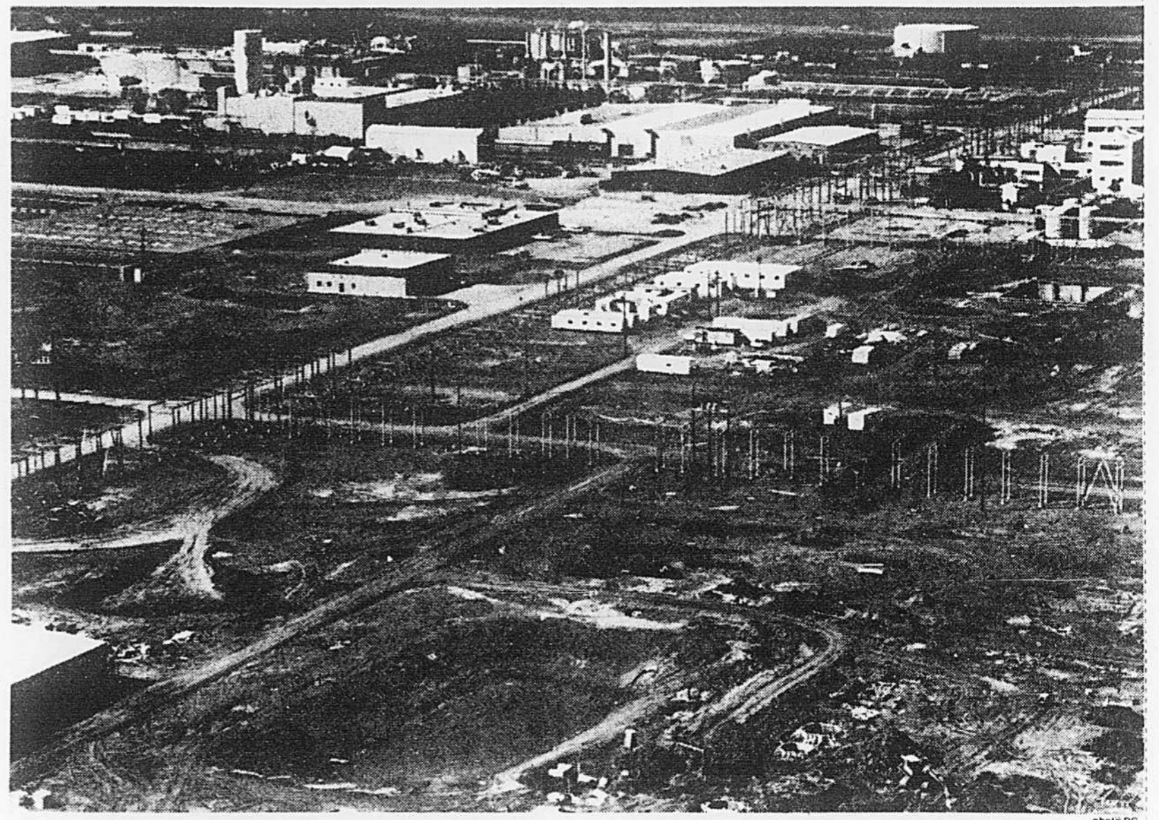
Les travaux se poursuivent au vaste Complexe pétrochimique d'Alberta, qui doit être achevé à la fin de 1980. Le projet, dont la réalisation coûtera $1,5 milliard, constitue le premier effort pour établir une industrie pétrochimique canadienne, en dehors de l'Ontario et du Québec, mais les responsables sont déjà confrontés à des problèmes de commercialisation.
