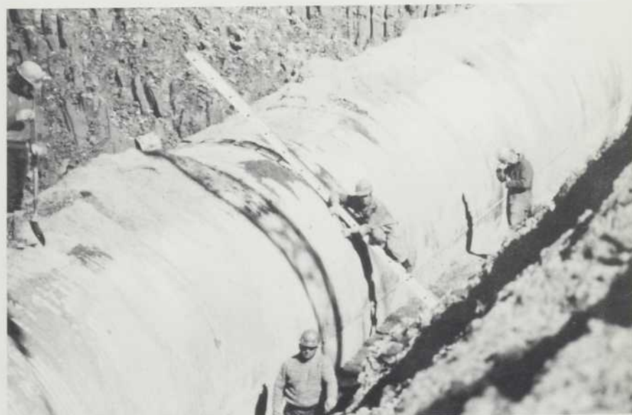
La conduite repose sur un lit de pierre concassée de 18 po. d'épaisseur.
