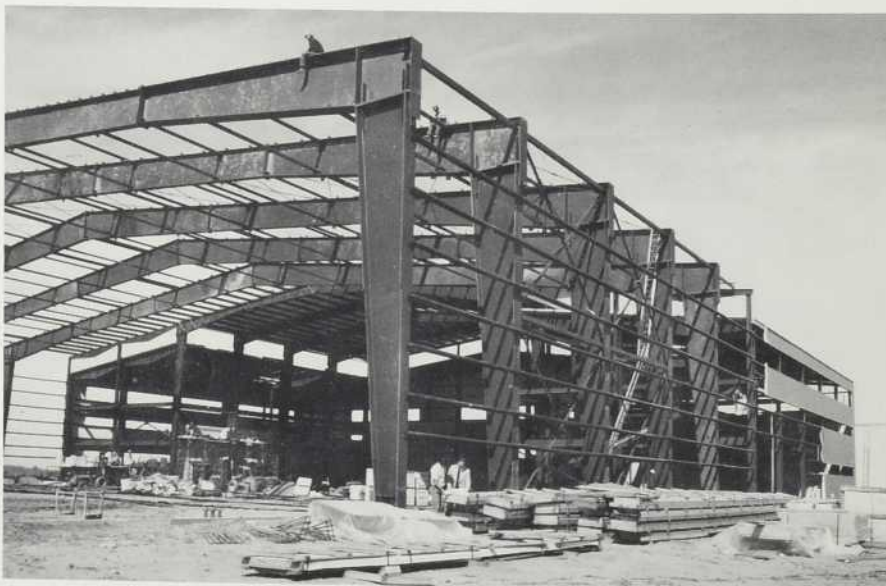
Ce hangar de 240 x 324 pi., à ouverture libre, a exigé des étréssillons à section creuse. Les boulons d'ancrage des colonnes ont été calculés comme s'il s'agissait de petites poutres travaillant en porte-à-faux.
