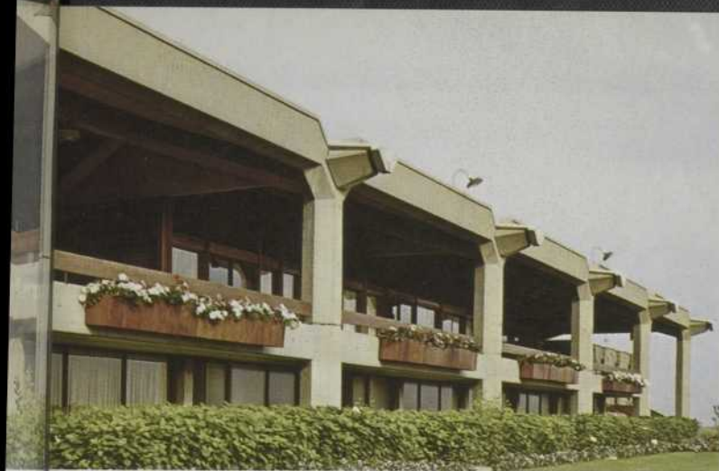
construit en béton coulé en œuvre, est à l'épreuve des incendies.
