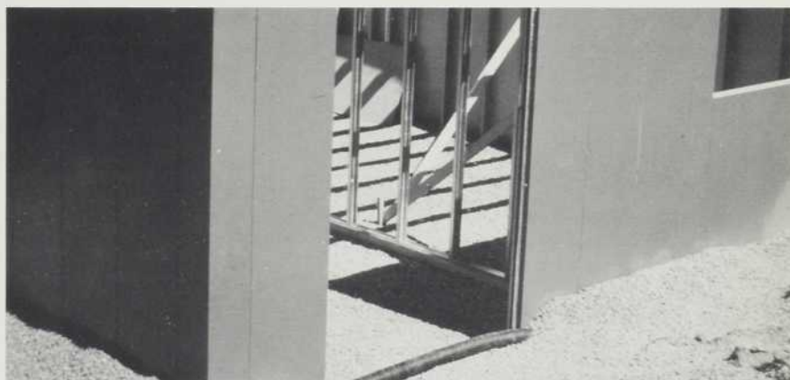
La maison repose sur un lit de gravier.
