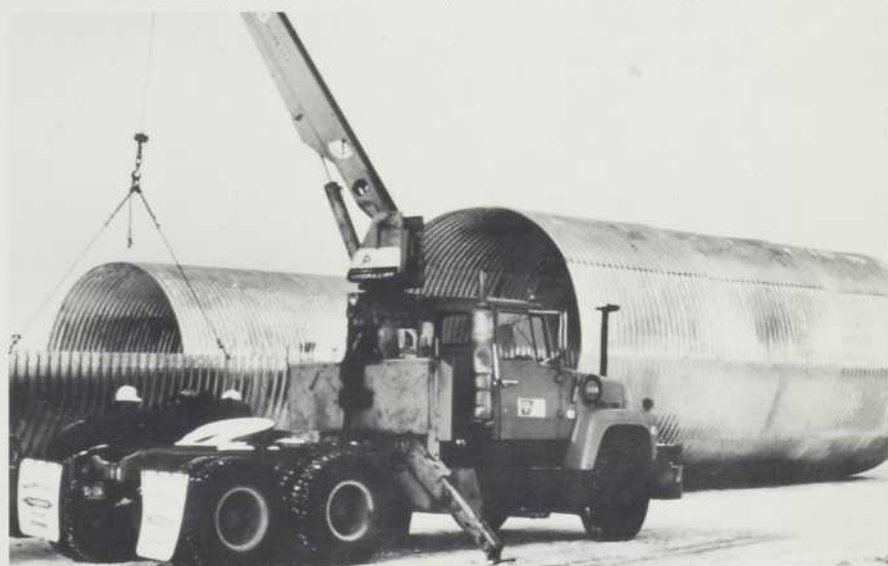
La cadence de production de conduite Armco Multi-Plate a été de 140 pi. par jour.
