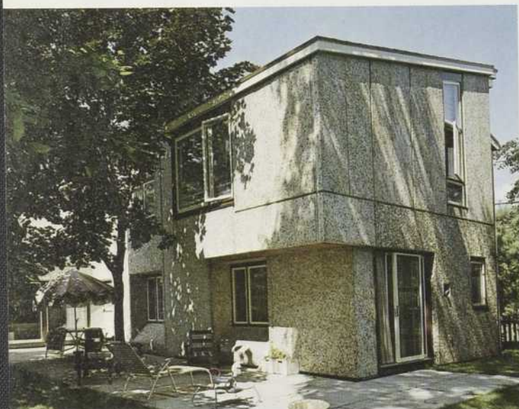
2 Maison tout en béton préfabriqué, à Ville Mont-Royal.
