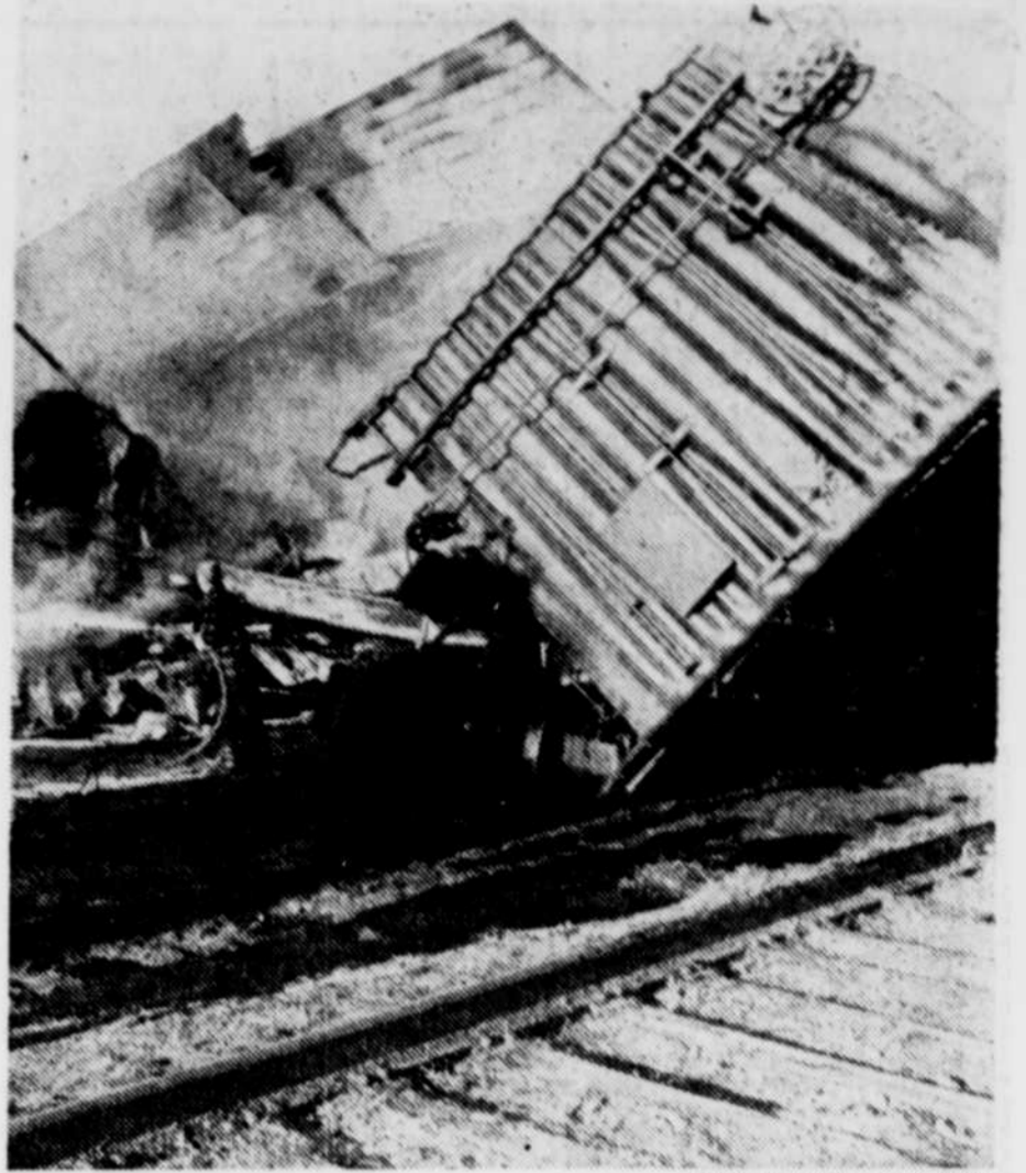
En s'écroulant, des silos ont renversé deux wagons du CN immobilisés sur une voie d'évitement.
