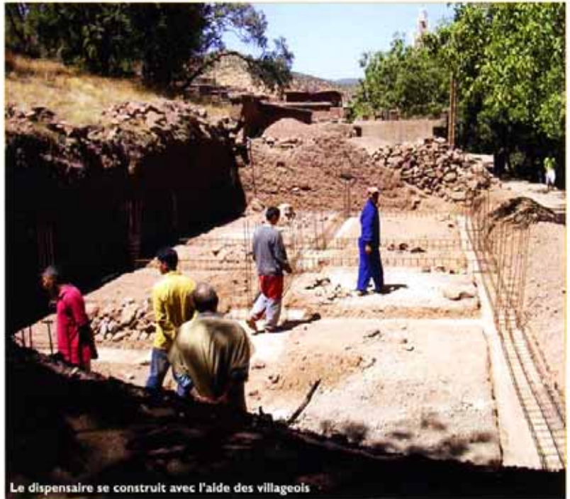
Le dispensaire se construit avec l'aide des villageois
