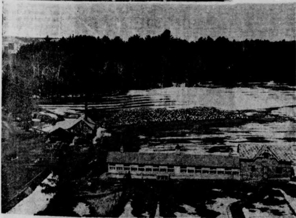
● Les Frères du Saint-Esprit construisent eux-mêmes les établissements de leur congrégation. Voici le moulin où, à la Pointe Gatineau, ils préparent le bois dont ils ont besoin. Au premier plan, les écuries et les étables.
