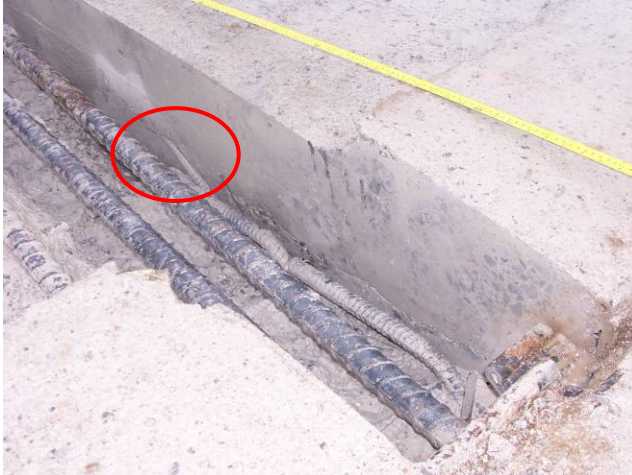
Diagonale plus élevée que la suspente en U sur de Blois (fenêtre centre-ouest)
