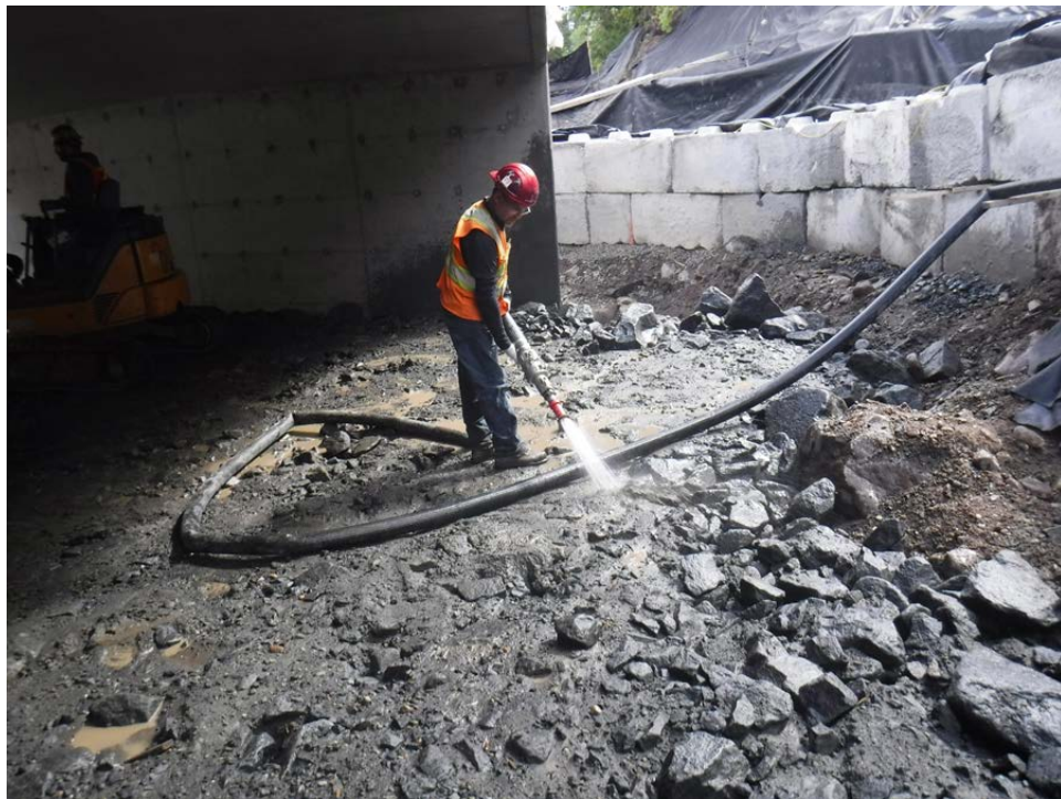
Figure 36 – Étanchéisation hydraulique et vérification des infiltrations (MTQ)
