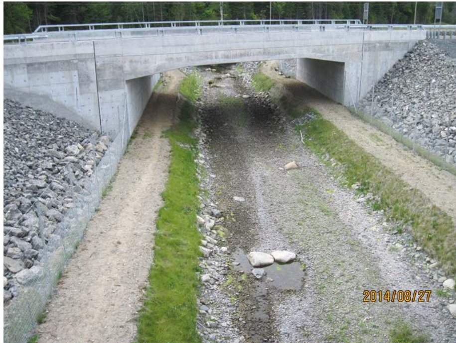
Figure 45 – Simulation aménagée sur un cours d'eau présentant une faible pente et présentant un mélange granulométrique peu étanche (exemple à ne pas suivre) (MTQ)
