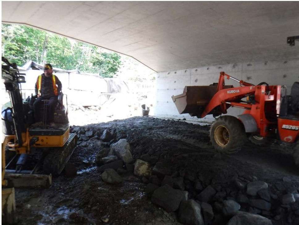
Figure 35 – Mise en place du mélange granulométrique et compaction (MTQ)
