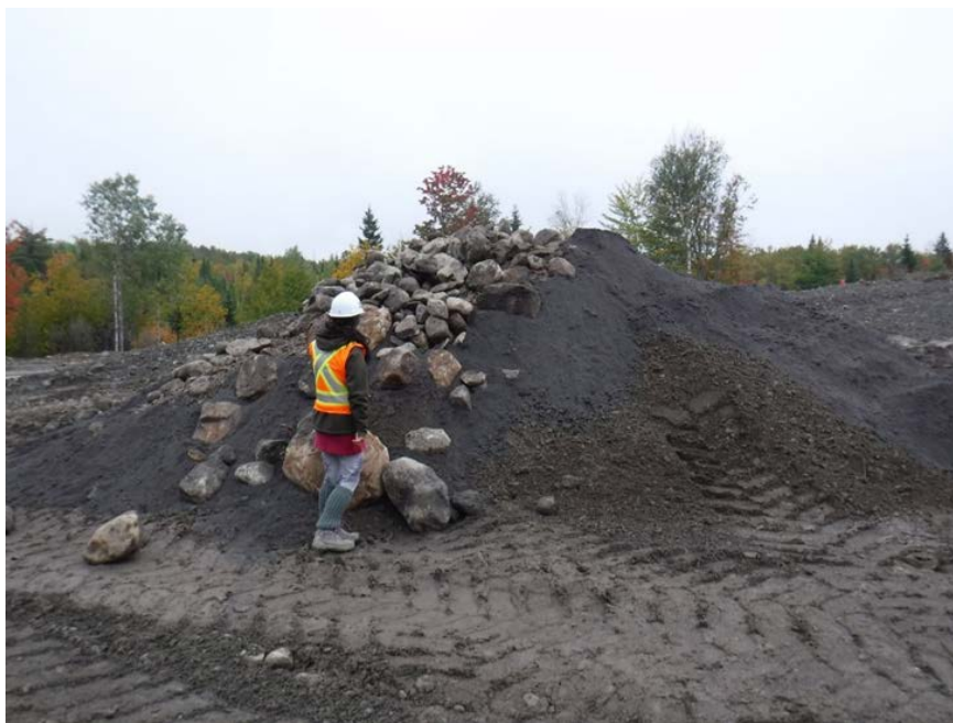
Figure 16 – Empilement de divers matériaux granulaires formant le mélange C (MTQ)
