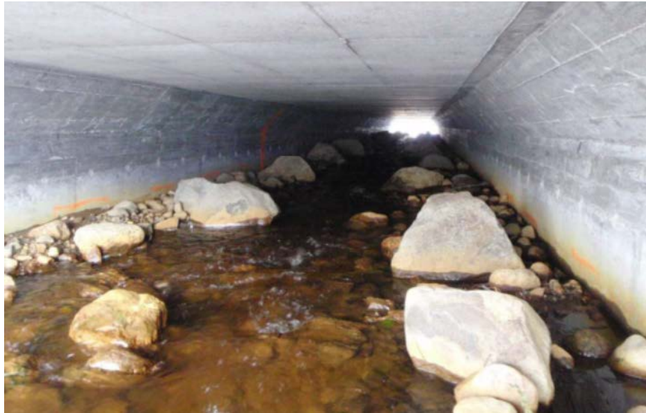
Figure 43 – Simulation aménagée sur un cours d'eau présentant un débit d'étiage d'environ 0,5 \text{ m}^3/\text{s} (exemple à suivre) (MTQ)
