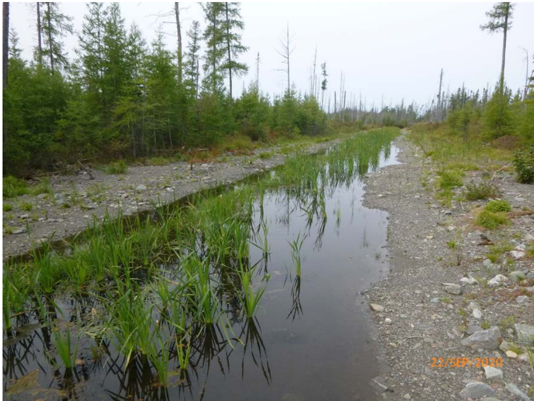
Figure 40 – Reconstitution de cours d'eau avec le mélange A (un an après les travaux) (MTQ)
