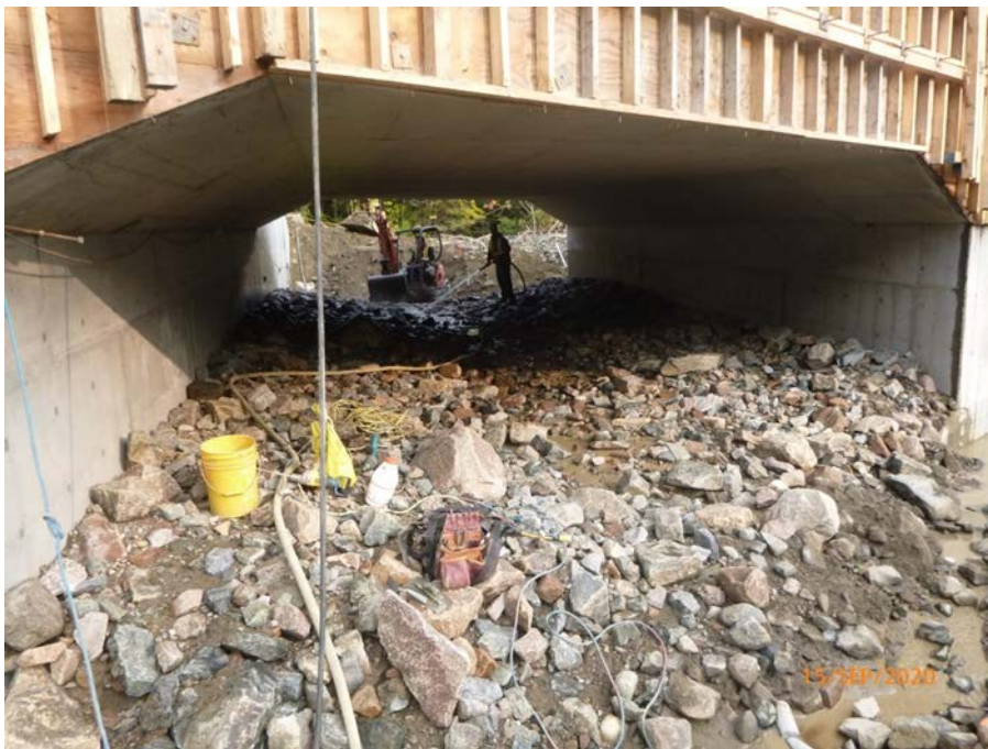
Figure 37 – Lavage des matériaux de surface et captation des sédiments (MTQ)
