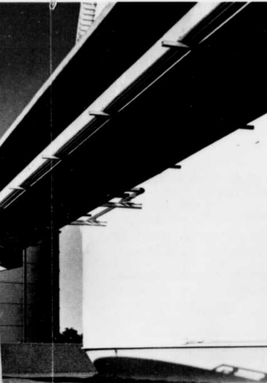
canalisations du Gaz Métropolitain, Montréal-Nord.
