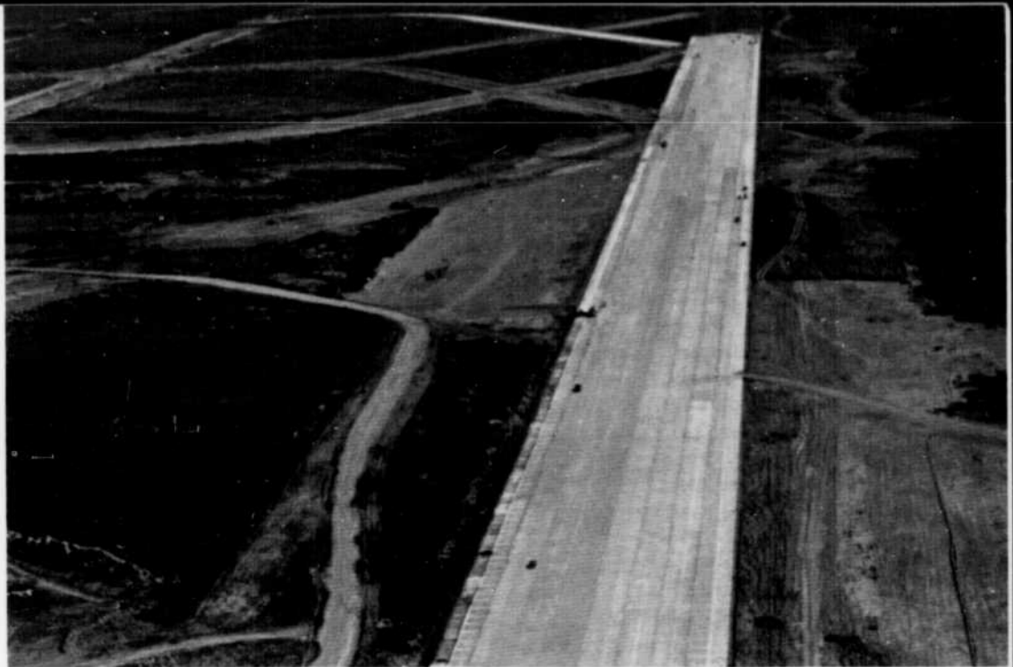
6. Une des pistes de béton du futur Aéroport International de Montréal, à Mirabel, Qué.
