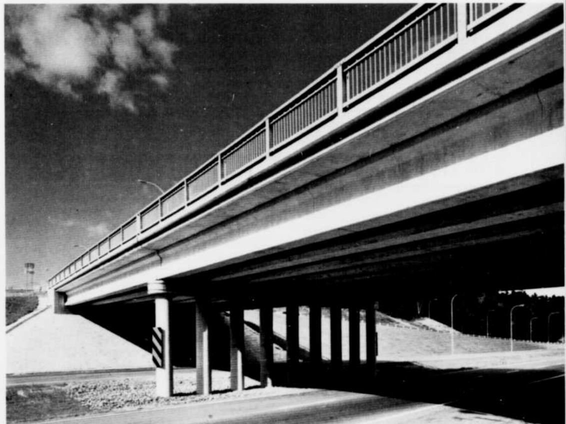
7. Viaduc en béton précontraint au carrefour du boulevard de Gaulle et de la route 640, Lorraine, Qué.
