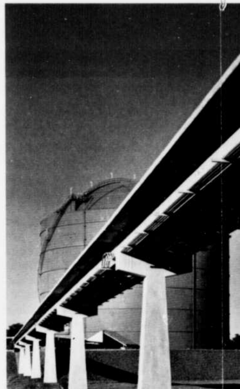
4. Supports de béton des canalisations du
