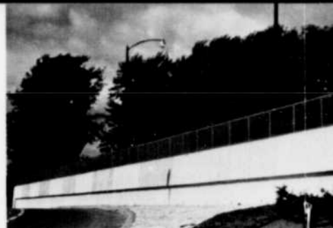
3. Un mur de soutènement solide et résistant.
