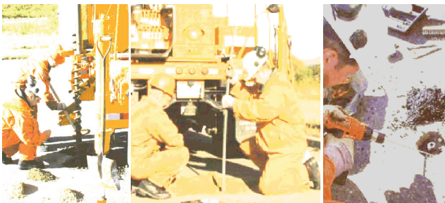
Installation d'un gelmètre dans la chaussée
