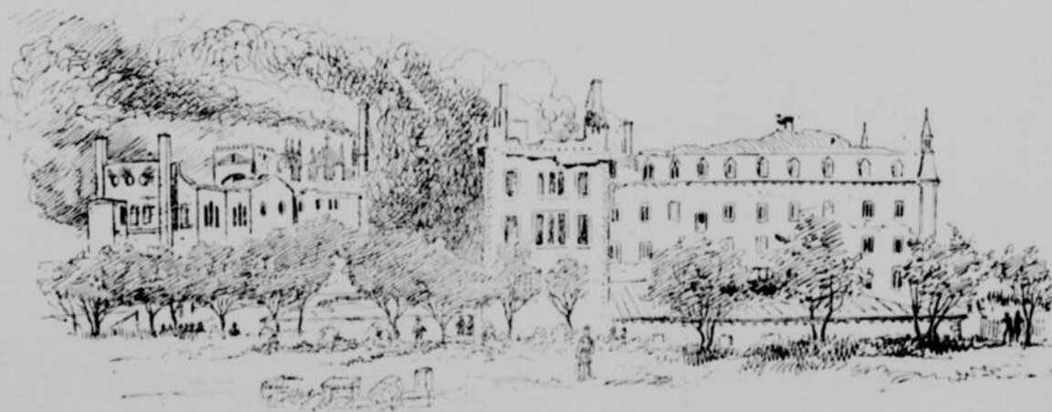
VILLA-MARIA. — Vue de l'incendie, à six heures p.m., de l'arrière
