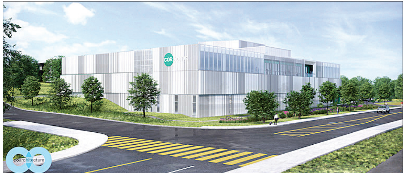
Coractive, dont la construction débutera cet été dans l'Espace d'innovation Michelet, à Québec.
