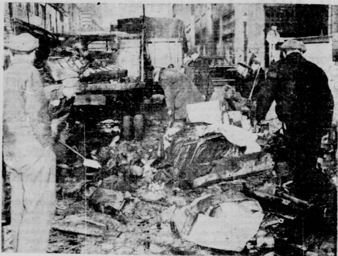
Peu avant neuf heures hier matin, un camion des messageries du chemin de fer Pacifique Canadien allait traverser l'angle des rues Metcalfe et Ste-Catherine, lorsque soudain, il prit feu, par suite de causes encore inconnues. Le véhicule transportait à ce moment des ballots de marchandises évaluées à plusieurs milliers de dollars dont on aperçoit ici les débris après que des "sauveteurs bénévoles" eurent aidé le conducteur du camion à répandre les marchandises sur la chaussée. Camion et marchandises ont été gravement endommagés.
