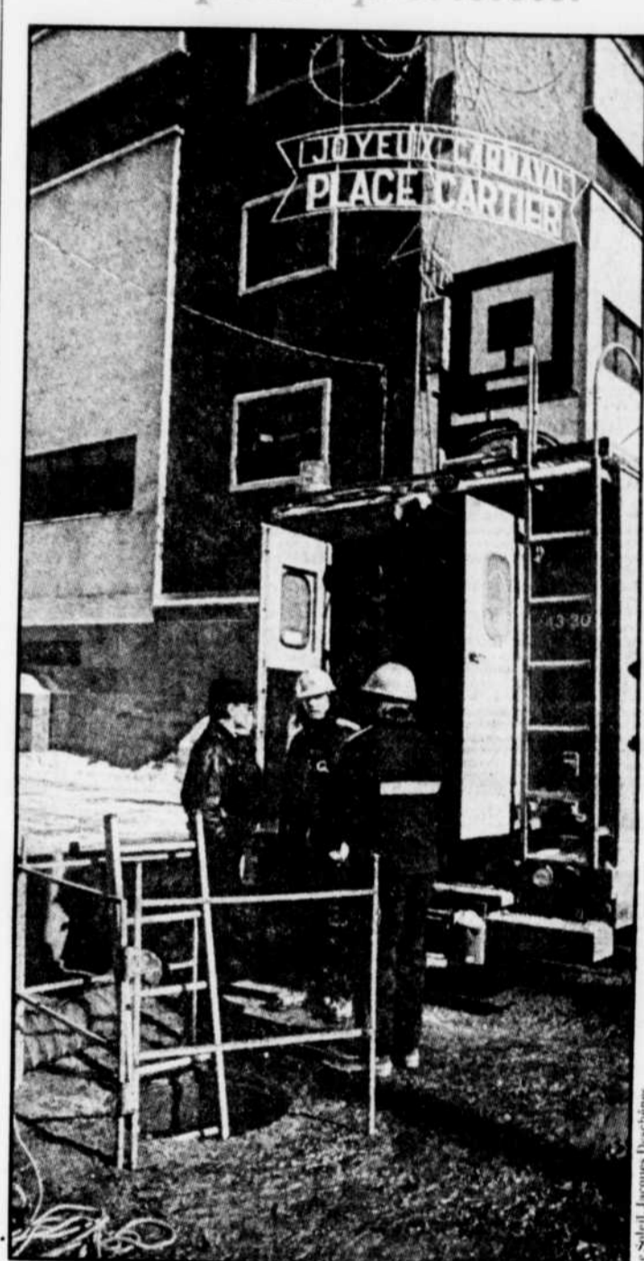
La panne d'électricité qui a affecté de nombreux commerces et bureaux du gouvernement dans le mail Centre-ville pendant 21 heures, hier, n'avait rien de surprenant. Des documents révèlent en effet de nombreuses faiblesses de simples câbles de relevé dans plusieurs secteurs et ce depuis longtemps.
