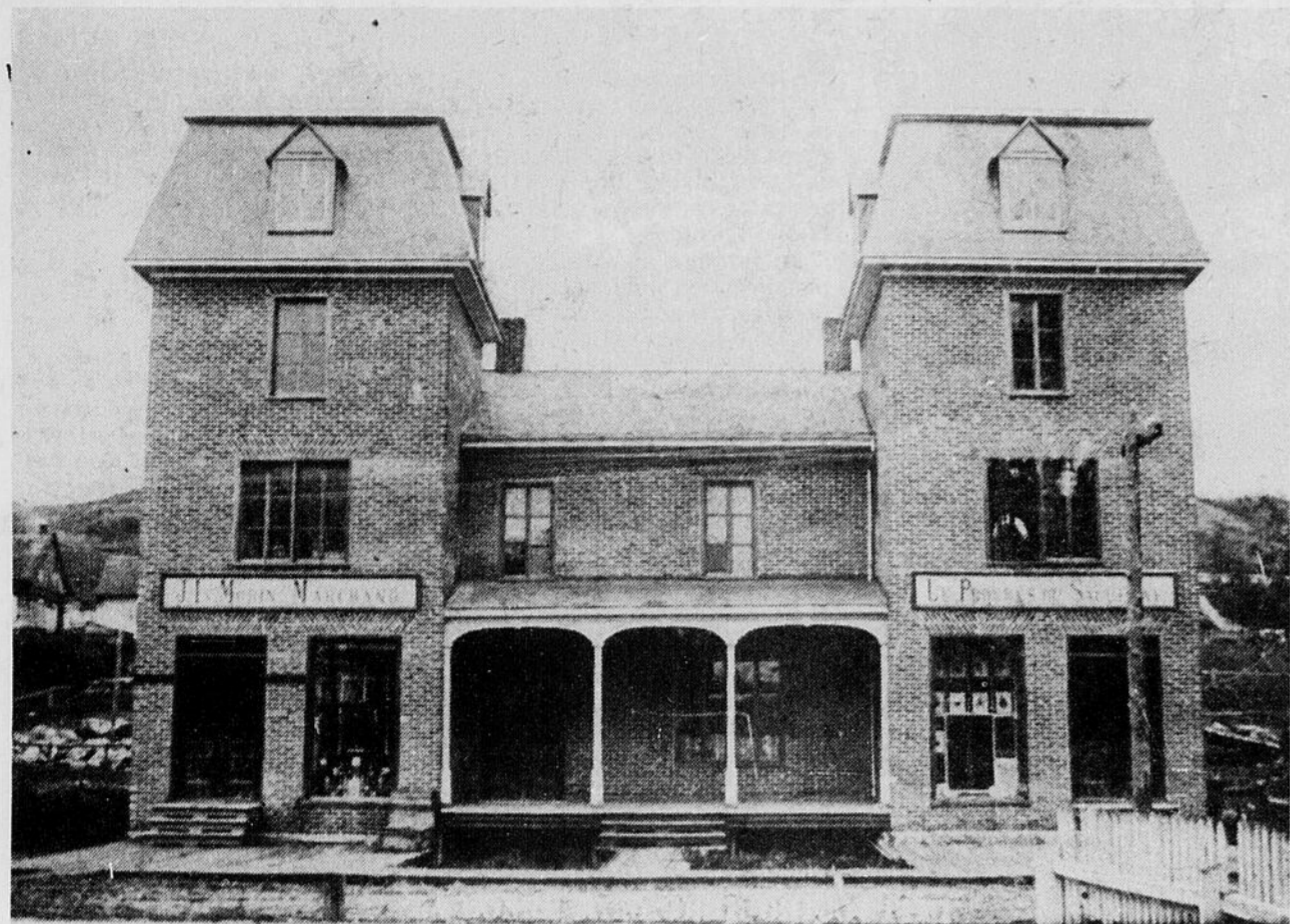
FIN 1889, DEBUT 1890 — Cet édifice que l'on appelait dans le temps "La bonne ménagère", a servi de local au Progrès du Saguenay durant
