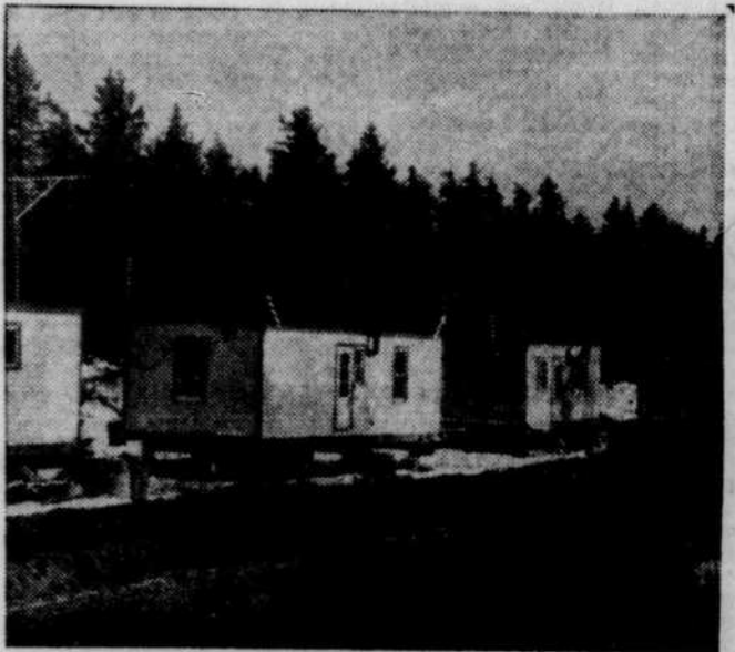
SUR LA ROUTE DE MATAGAMI — Simard et Frères d'Amos construisent une magnifique route entre Amos et le lac Matagami. Plus d'une centaine d'hommes logent dans ces confortables camps.
