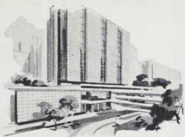
ÉDIFICE À BUREAUX
