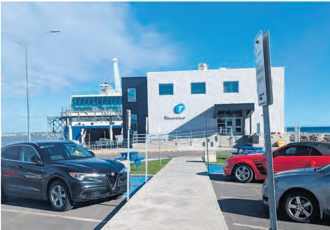
Des travaux de réparation à l'embarcadere de la Société des traversiers du Québec à Matane entraîneront une interruption de service les 20 et 21 septembre. Photo STQ
