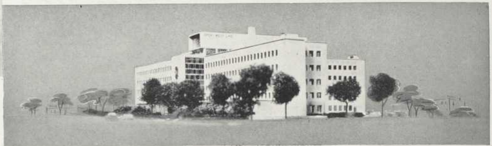
Siège social — Architectes: Marani & Morris, Toronto The Great-West Life Assurance Company, Moody & Moore, Winnipeg Winnipeg Constructeur: G. A. Baert Construction Co. Ltd., Winnipeg
