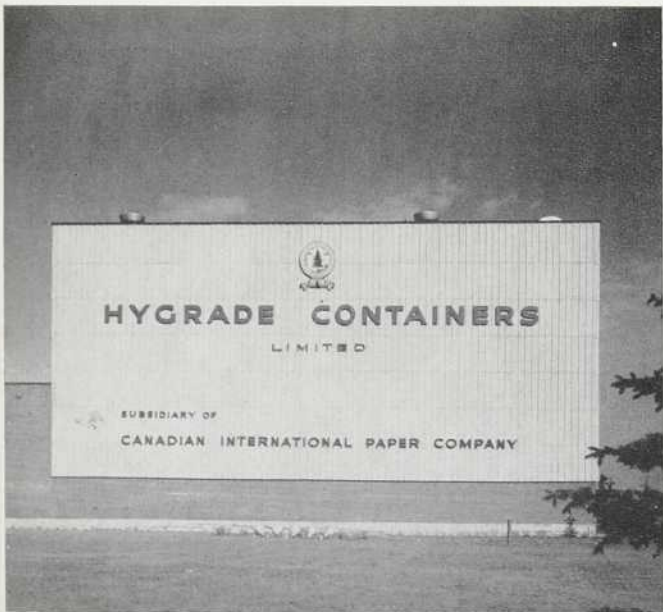
Page précédente, vue générale prise de la rue Sherbrooke. Ci-contre, détails de façade.
