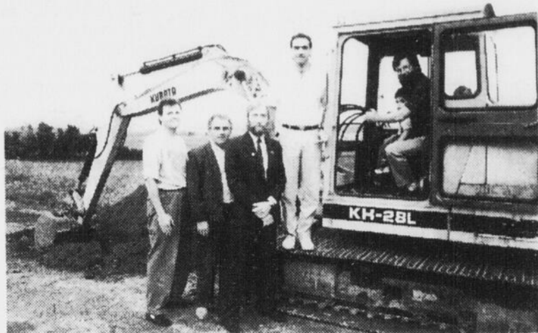
CHALET — L'architecte Serge Harvey, le contremaître Maurice Duchesne, le maire Jacques Dallaire, le dg du centre Mont Lac-Vert Alain Girard et le président de la corporation Antonin Colard ont procédé à la levée de la première pelletée de terre pour la construction d'un chalet.
