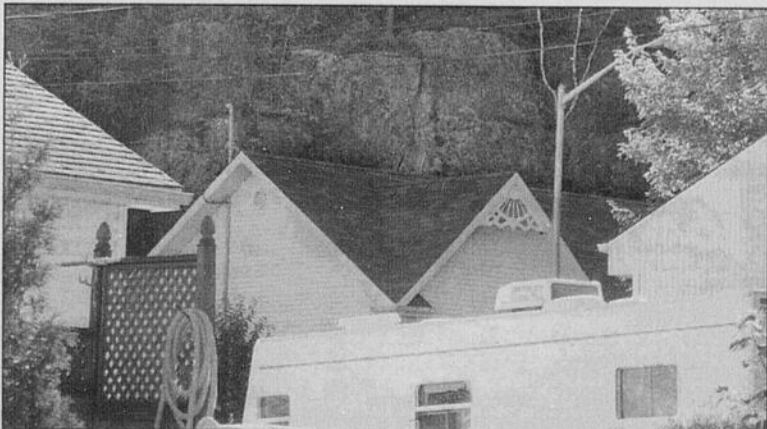
PAROI - Saguenay doit aller en appel d'offres pour faire réaliser des études plus approfondies sur la paroi rocheuse située derrière les résidences de la rue Marco.
