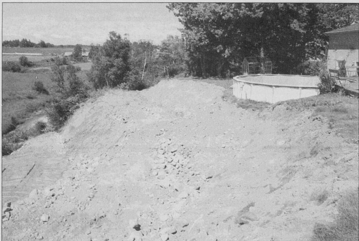
TRAVAUX - Un aperçu des travaux de stabilisation effectués chez l'un des propriétaires sinistrés.
