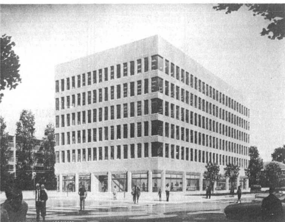
Un immeuble professionnel et commercial de 6 étages, situé à l'angle Côte des Neiges et de la Peltre, au coût de $2 millions. Les baies d'angles sans montant d'arête sont scellées de façon à ne pas obstruer la vue vers l'extérieur.
