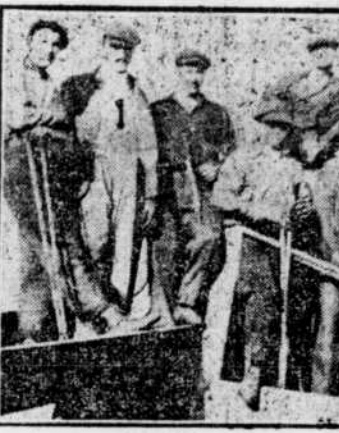
LA CATASTROPHE DU PONT DE QUEBEC.—Groupe d'ouvriers travaillant à la construction du pont. No 1, M. Henri Vandal, qui l'on rapporte comme noyé. No 2, M. Alex. Barbeau, qui est tombé en bas du pont, au moment du désastre.
