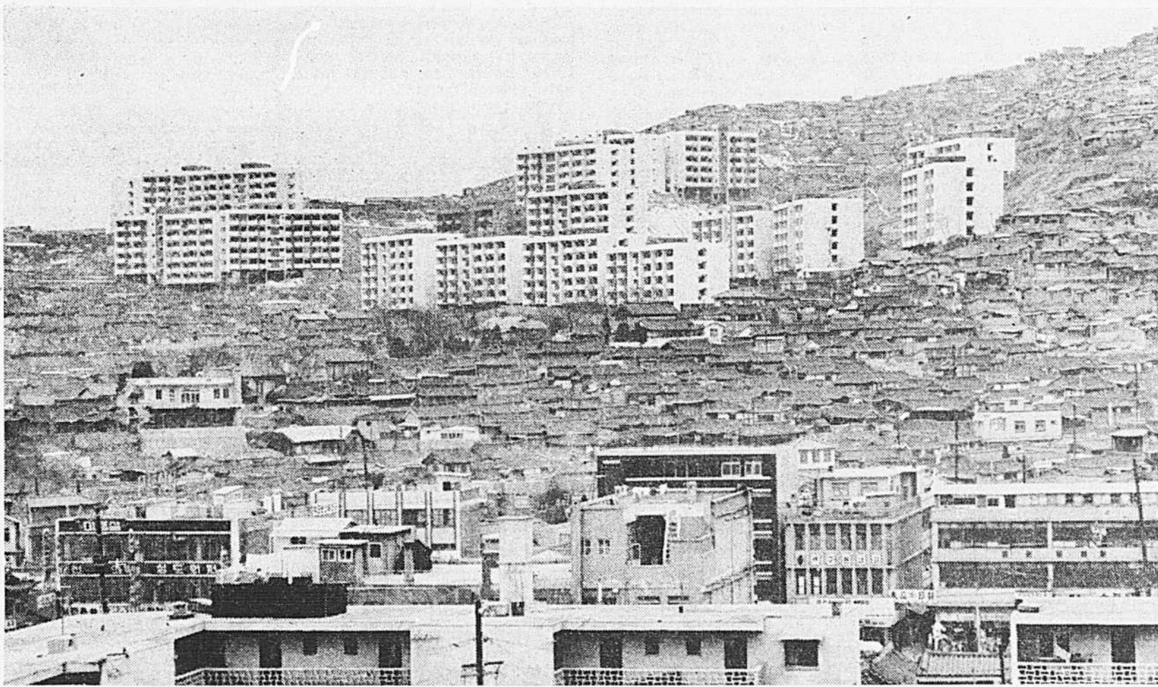
Un signe de la prospérité de Séoul, capitale de la Corée du Sud: au-dessus des milliers de cases qui couvrent les flancs des collines autour de la ville, se dressent les HLM de la rénovation.
