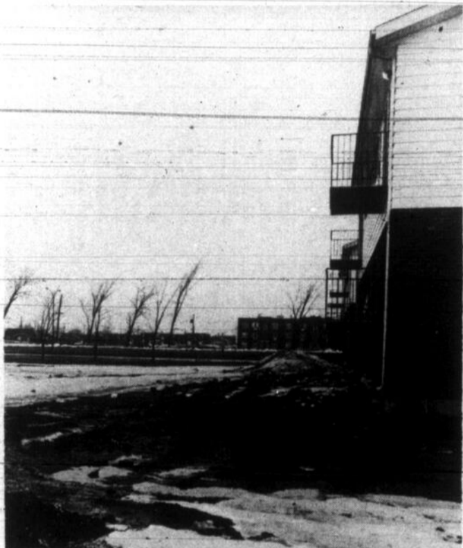
Les travaux de terrassement seront terminés en juillet. Par contre, l'intérieur des maisons sera complété à la mi-avril.
