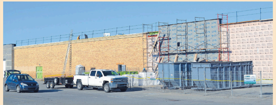
Les travaux dans le nouveau local de l'Aubainerie avancent bien selon le propriétaire franchisé, Martin Croteau. (Photo: Granby Express-Éric Patenaude)
