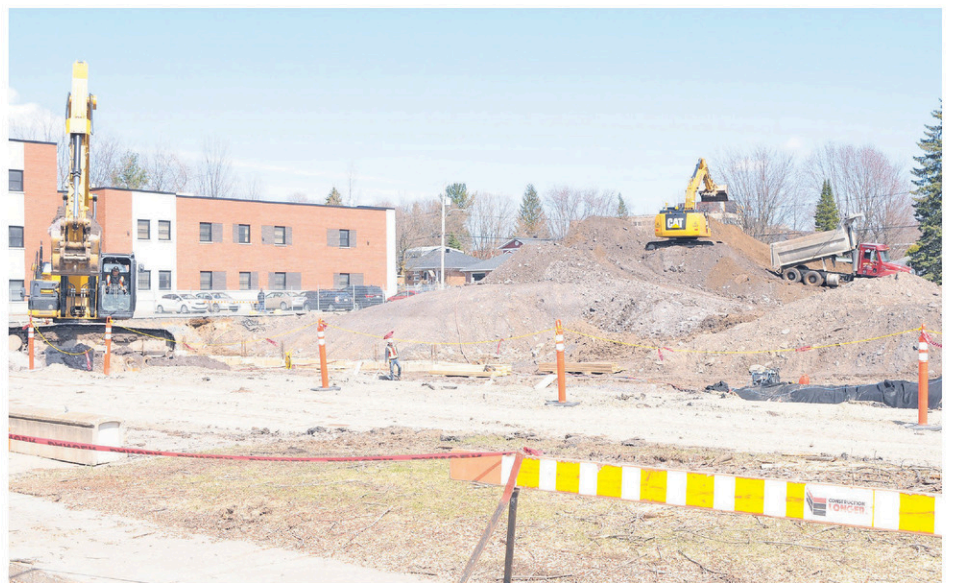
Voici à quoi ressemble le chantier actuel du nouveau CHSLD de Granby.
