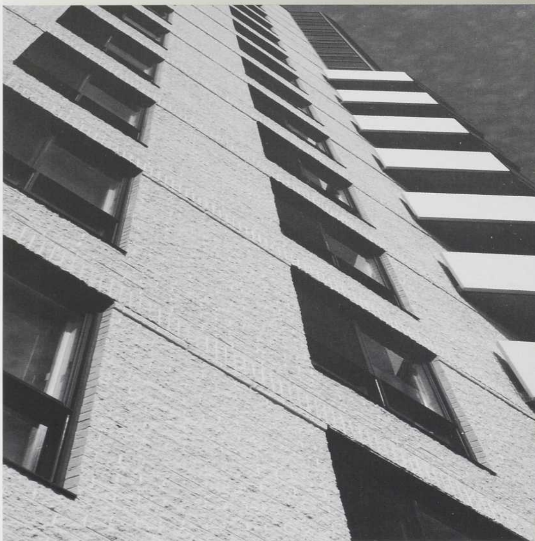
LE CONDOMINIUM RIVE-GOUIN (514) 325-0680 — REMO CONSTRUCTION INC. — ARCHITECTES: DESMARAIS PILON COUSINEAU YAGHJIAN ST-JEAN ROGERS
