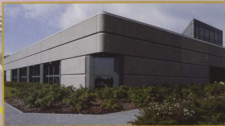
Usine d'épuration des eaux de la Communauté Urbaine de Québec
