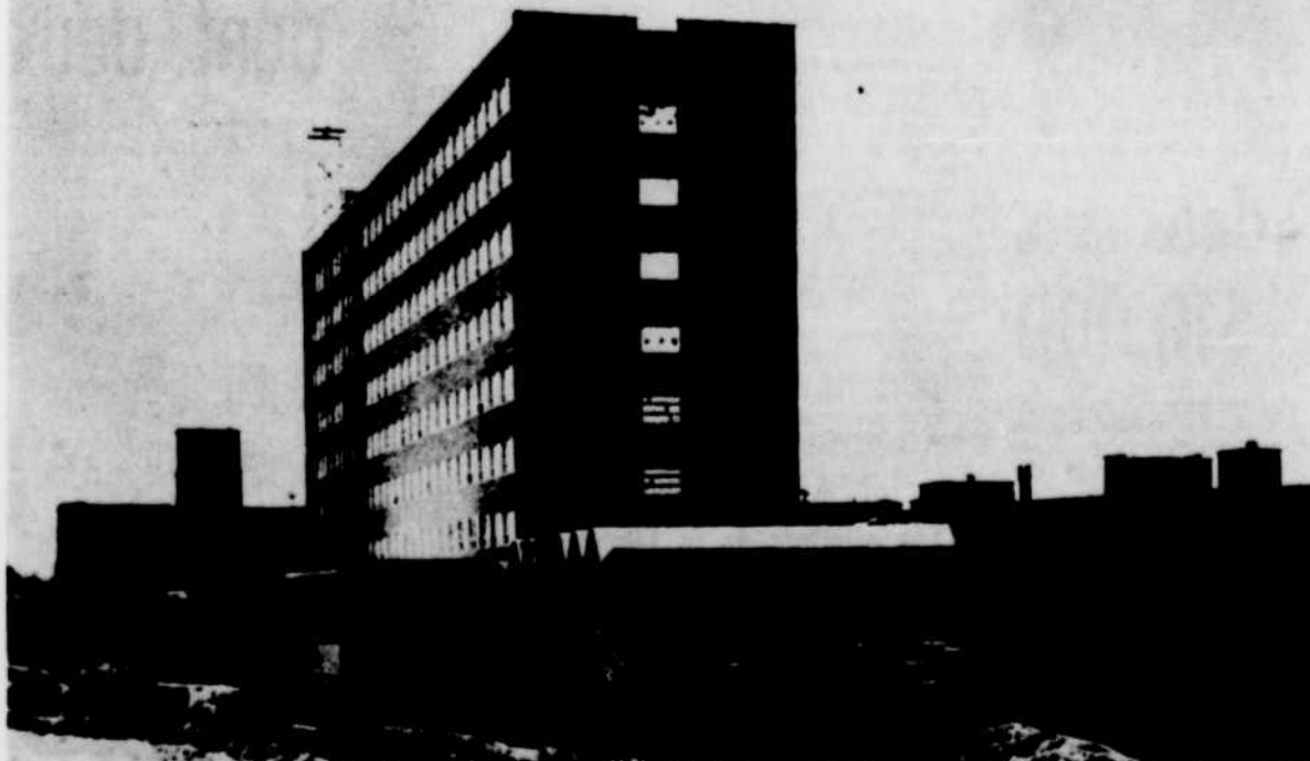
L'ARCHITECTURE A LA BRUNANTE. — Les travaux de construction de l'école et de la résidence des infirmières de l'Hôtel-Dieu progressent rapidement, à Sherbrooke. Sur cette photo, le soir tombe sur les travaux. (Photo La Tribune, par Jacques Darche)
