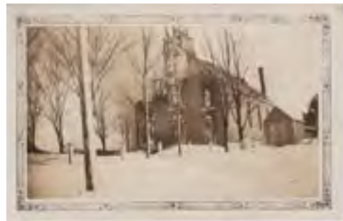
1933, Destruction par le feu de l'église paroissiale de Saint-Hippolyte. Collection Famille Dagenais
