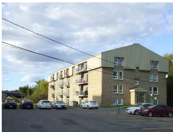
Immeuble de la rue Côté
